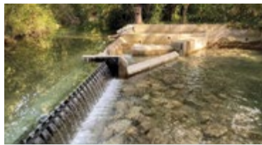
Passé du Moulin des Toiles Entraigues sur la Sorgue
