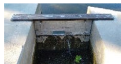
Amélioration du verrouillage du batardeau
