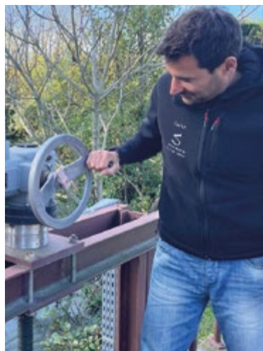
Jérémie réalisant les premières manoeuvres de l'ouvrage des 7 Espassiers.
