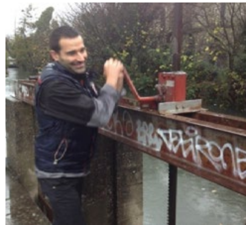
Manœuvre manuelle des vannes d'Air Liquide - Vedène
