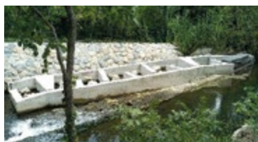
Passé à poissons de Saint Albergaty - Monteux
